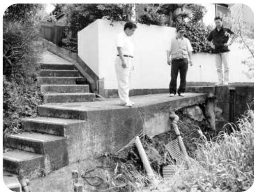
△手すり設置で歩行者の安全対策(江平町)
